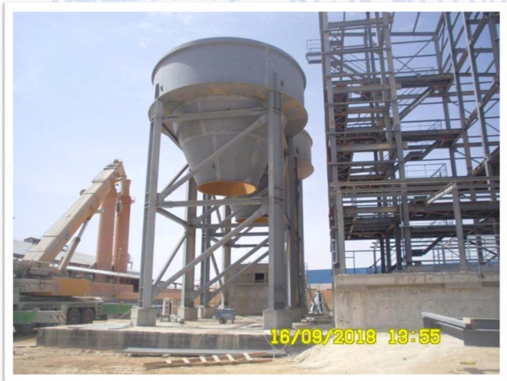
Mission de Suivi travaux de réalisation d'une unité d'ensilage pour l'unité commerciale Touggourt – dépôt Ouargla « SCIMAT » d'une capacité de 1600 tonnes / heures
